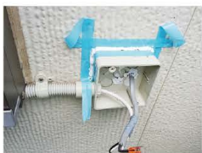
2 電源とソムフィキットを接続し、防水処理を行います。
