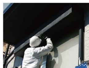
8 フタを閉めて完成です。
