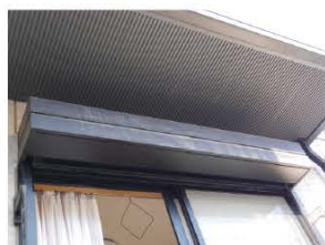
1 工事前のシャッターボックスです。
