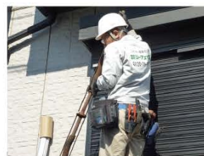
4 古い芯棒を取り外します。
