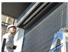
7 ソムフィキットとシャッターを繋ぎます。
