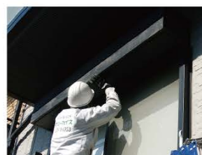
8 フタを閉めて完成です。
