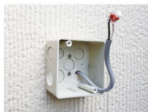
1 窓の近くの電源を分岐。外壁に電源ボックスを取り付けます。
