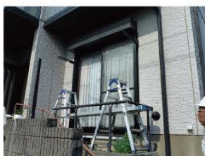
2 窓の外側に足場を設置します。作業はほとんど屋外です。
