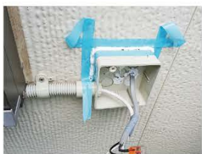
2 電源とソムフィキットを接続し、防水処理を行います。
