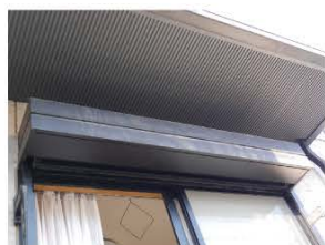
1 工事前のシャッターボックスです。
