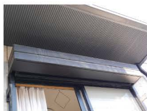
1 工事前のシャッターボックスです。
