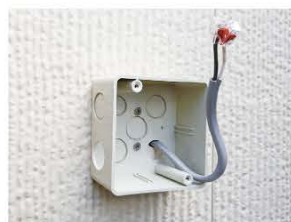
1 窓の近くの電源を分岐。外壁に電源ボックスを取り付けます。
